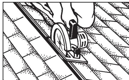
Étape 2 – Découper la fente (coupe verticale de tête si possible). Remarque : ajuster la profondeur de la lame pour éviter de couper les chevrons ou les fermes. Référez aux dessins pour les dimensions des fentes. Éliminer les débris se trouvant dans les fentes.
