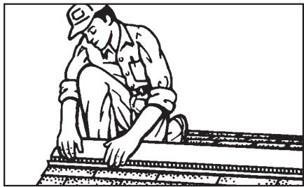
Paso 3 – Estire y centre la ventilación sobre la ranura. El final debe estar alineado con el final del techo. Asegúrese de que los laterales de sostén de la ventilación se encuentren bien apoyados sobre el techo y que el filtro para CertainTeed Rolled Ridge Vent Filtered esté bien colocado entre las tejas y la ventilación.
