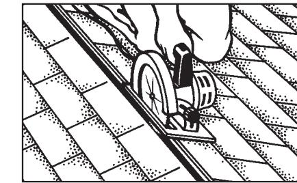
Paso 2 – Haga la ranura (de ser posible, haga un corte vertical). Nota: Ajuste la profundidad de la cuchilla para evitar cortar vigas y cerchas. Consulte los dibujos para ver las dimensiones de las ranuras. Retire los restos de la ranura.
