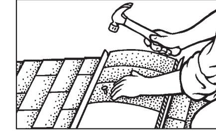
Paso 5 – Clave las tejas en su lugar utilizando clavos para techo con el largo suficiente para penetrar la cara inferior del techo.
