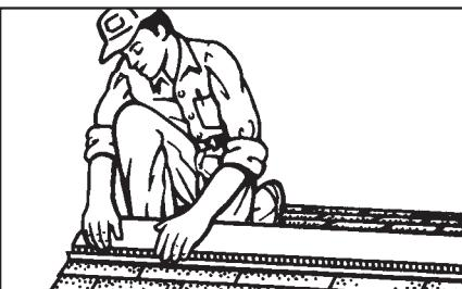
Étape 3 – Dérouler et centrer le système de ventilation sur la fente. L'extrémité de l'évent devrait être en ligne avec l'extrémité de la toiture. S'assurer que les murs de support du système de ventilation soient bien étendus sur la toiture et que le filtre du système de ventilation par faîtement CertainTeed soit bien sécurisé entre les bardeaux et le système de ventilation.
