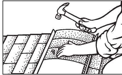
Étape 5 – Clouer les bardeaux de faîtement en place en utilisant des clous de toiture suffisamment longs pour traverser le platelage de la toiture.
