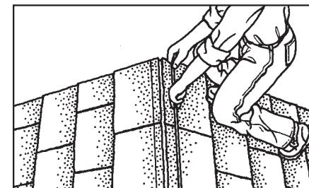
Étape 1 – Sur les toitures existantes, enlever les bardeaux de faîtement. Marquer la largeur de la fente aux deux extrémités du faîtement. Utiliser les guides de fente imprimés sur le système de ventilation et référer aux dessins à l'endos de cette page. Utiliser le cordeau de chaque côté du faîtement pour marquer les fentes.
